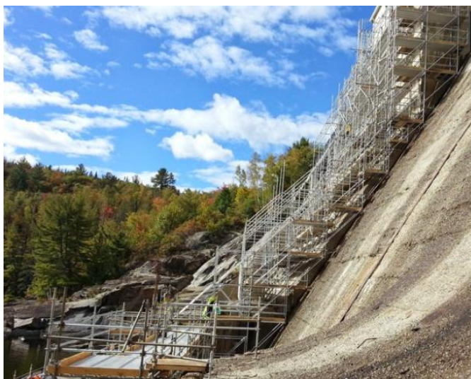
図 34 システム足場
